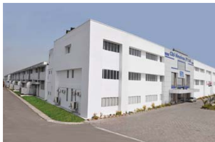
CONTROLS & SWITCHGEAR HIMOINSA Pvt. Ltd
