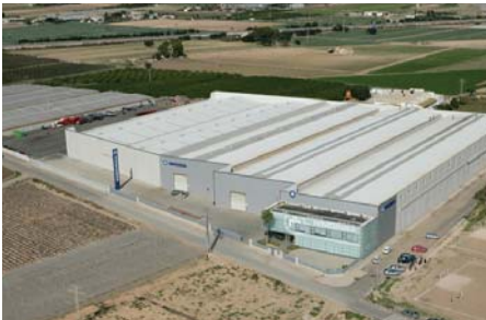
HIMOINSA T. OF METAL 1
