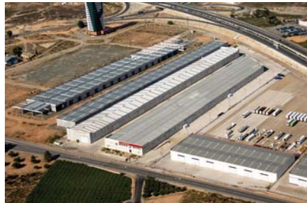
HIMOINSA T. OF METAL 2
